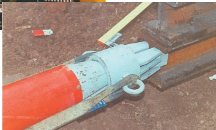
Rohrvortriebsmaschine Typ OLYMP beim Vortrieb IPB 180 mm.
