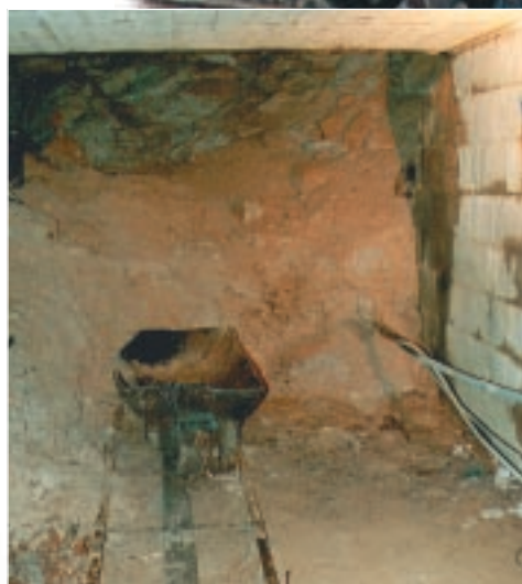
Das Haufwerk des eingestürzten St. Barbara Stollen.
