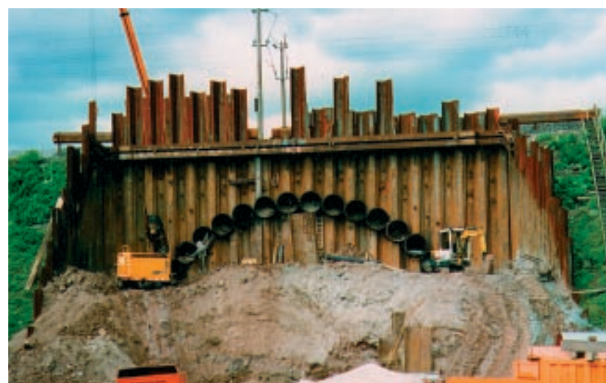
Die erste Phase des Tunnelvortriebs.
