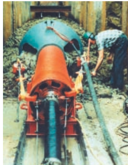
Entleerungskegel für die selbstgehende Abförderung des Bodens beim Vortrieb (Teilentleerung während des Vortriebs).
