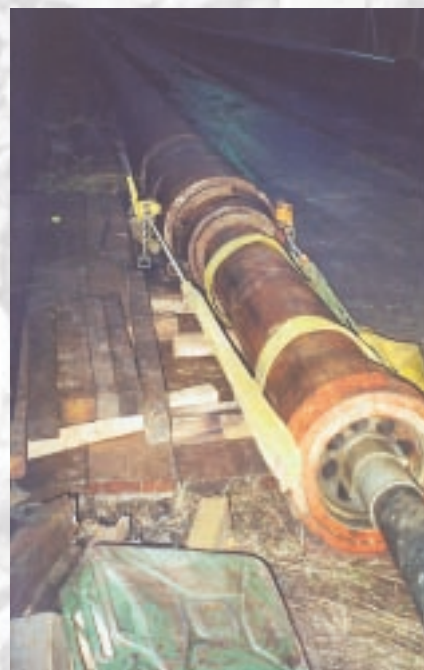
Die KOLOSS-Rohrramme am Ende des Rohrstranges.
