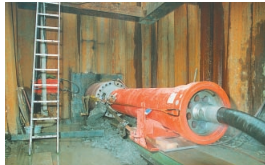
Vorne am Verbau ist die Dichtmanschette zu erkennen, die verhindert, daß Grundwasser in die 9 Meter tiefe, 16 Meter lange und 4 Meter breite Baugrube dringt.
