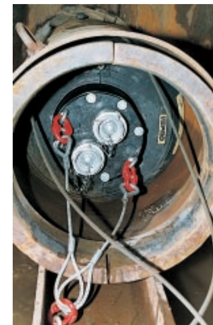
Die Dimension der Baugrube mit dem eingebauten Dichtkissen im Rohr.
