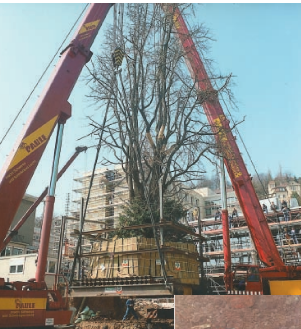
Die Umsetzung des 150 Tonnen schweren Ginkgo-Baumes.
