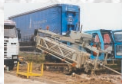
Der GRUNDODRILL 20 S im Einsatz.
