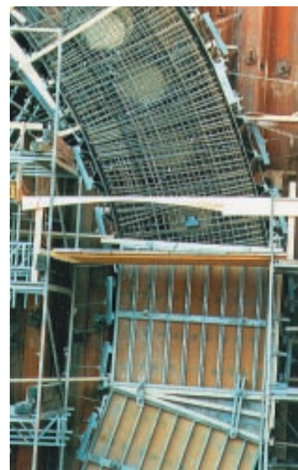
Im April 1995 entstanden diese beiden Bilder mit dem verschalteten Rohrschirm und dem bereits sichtbaren Teil des Stahlbetonringes.
