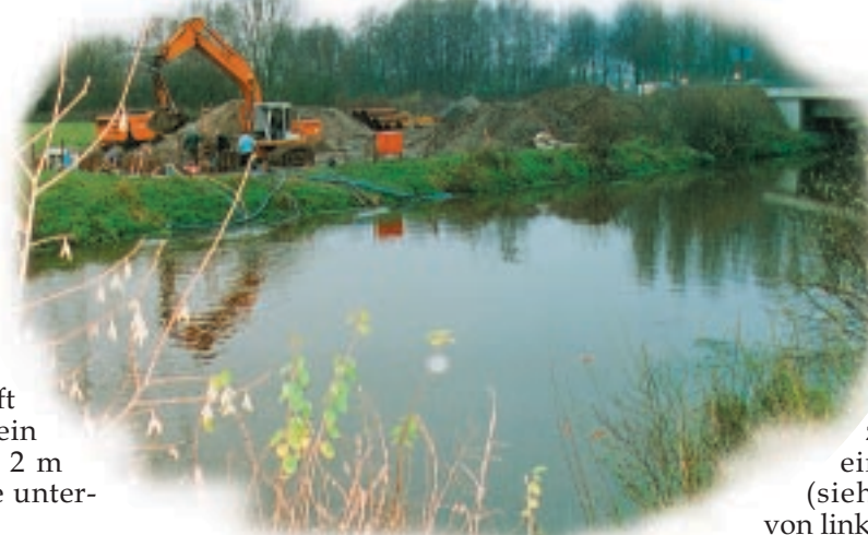
◀ Blick über die Erft zur Startgrube.
