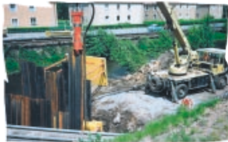
Fotos: Abrammen einer Spundwand mit GRUNDORAM. Vorbereitung der Ortsbrust für den Stahlrohrvortrieb in Bodenklasse 6. Am Stahlrohr ein montierter Schneid Schuh. Der Vortrieb erfolgte mit dem KOLOSS auf 17 m Länge; Entleerung mit Hand- und Preßluftwerkzeug.
