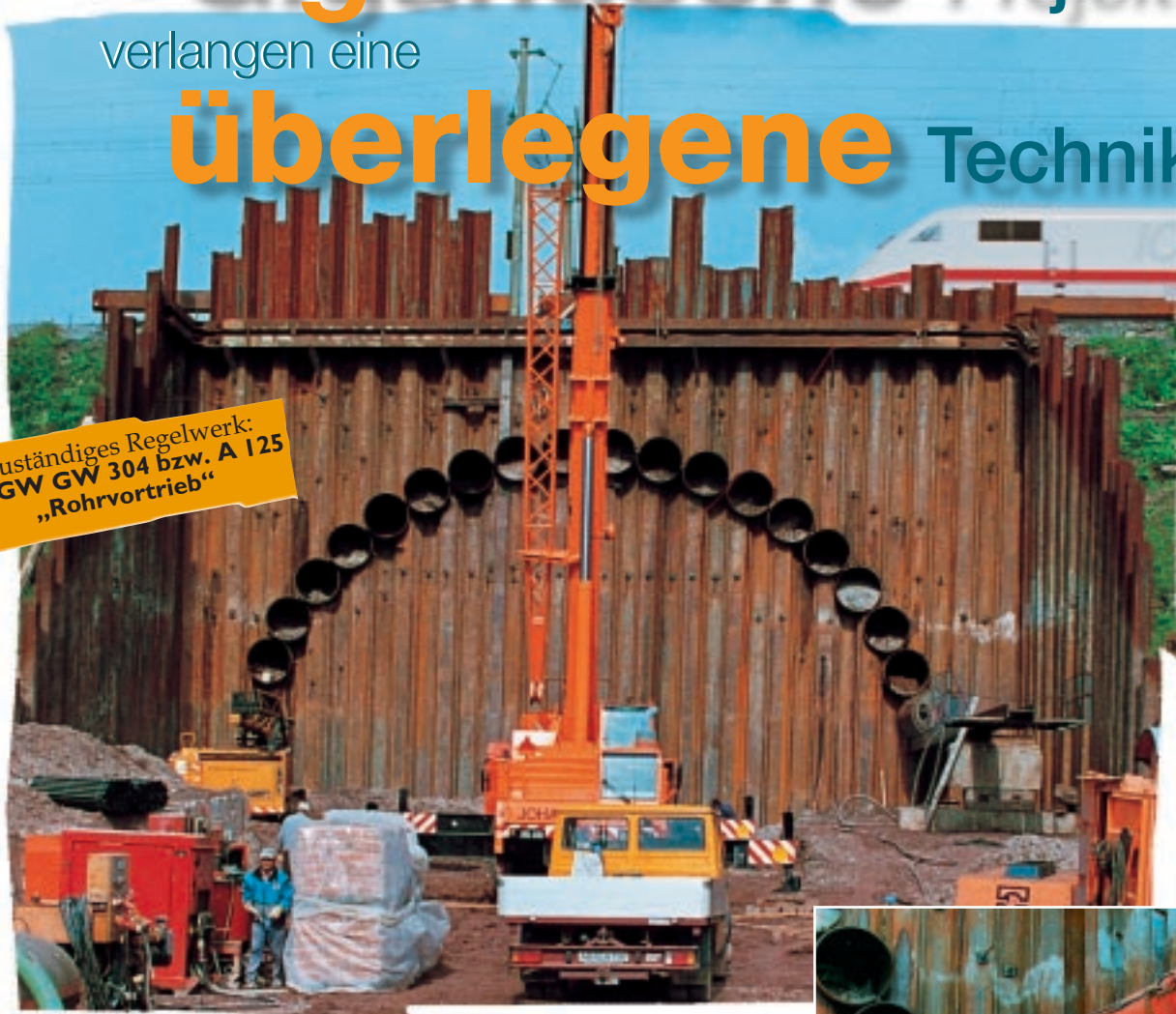
Spektakulärer Tunnelvortrieb bei Emskirchen / Nürnberg mit der GRUNDORAM-Technik.
