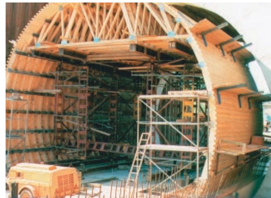
Außerhalb des Rohrschirms wurden die einzelnen Betonier-Abschnitte (Stärke 70 cm) mit einem Traggerüst und mit dem Schalwagen hergestellt. Danach wurden die Abschnitte mit einer hydraulischen Presse eingeschoben, der Schalwagen wurde gelöst und für den nächsten Abschnitt herausgefahren.
