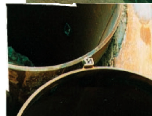
Mit Spundwandschlössern werden die Rohre exakt geführt.
