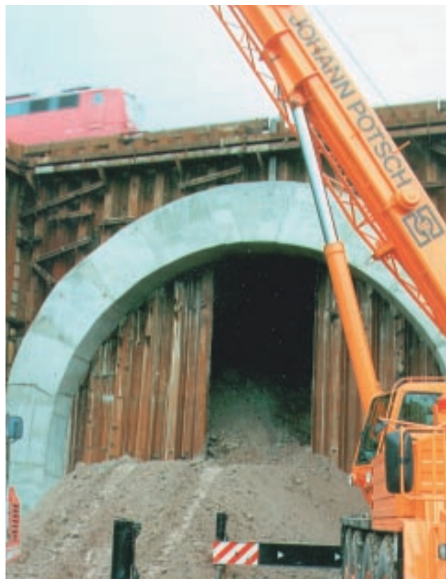
Die Spundwand wurde mittig aufgeschnitten und mit dem Aushub im Fangedamm begonnen.
