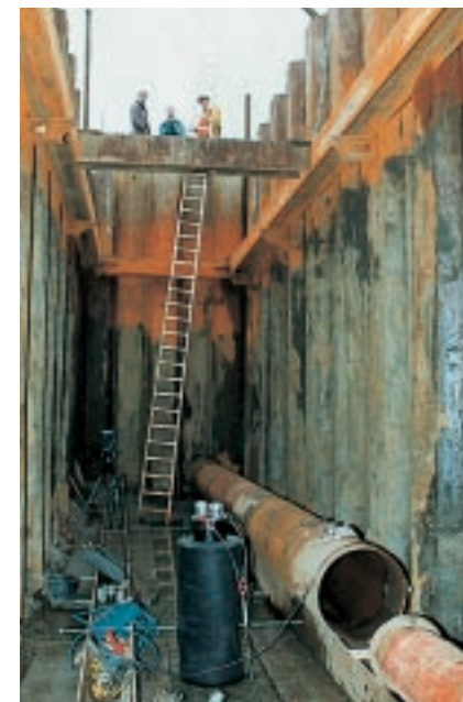
Die Dimension der Baugrube mit dem eingebauten Dichtkissen im Rohr.
