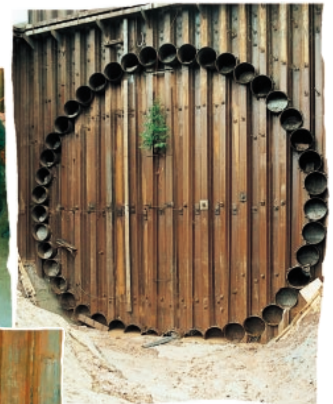
◀ 180 Dywidag-Gewindestähle wurden für die Verankerung der Spundwände im „Fangedamm“ verankert.
