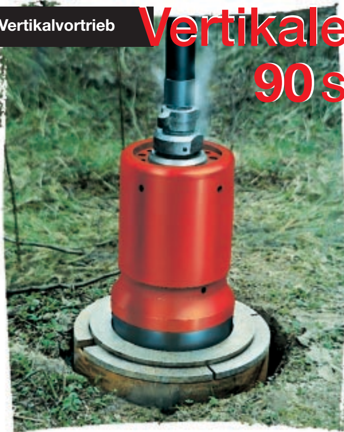
Im Rohr eingelassener Mini-GIGANT beim Vortrieb.
