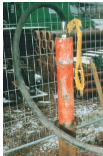
Das konische Stahlrohr, das mit GRUN- DORAM, Typ MINI-OLYMP, vertikal ein- geschlagen wurde für die Ermittlung der Druckbelastbarkeit. Durch die angebrach- ten "Flügel" läßt sich das nächste Rohr- stück leicht aufsetzen und verschweißen.
