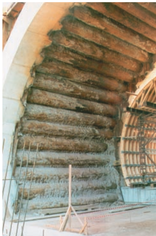
Die geräumte Unterführung. Im Hintergrund der 8 m lange Schalwagen für die Herstellung der 7 Betonier-Abschnitte.
