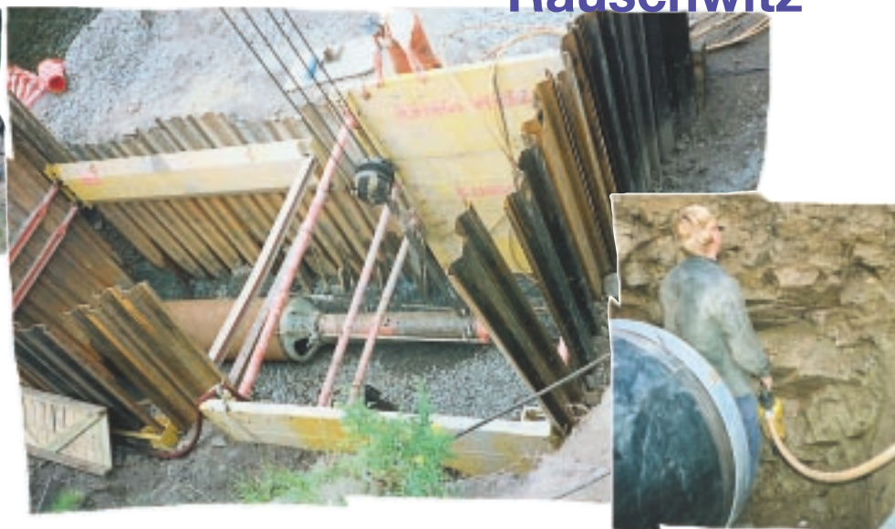
Fotos: Abrammen einer Spundwand mit GRUNDORAM. Vorbereitung der Ortsbrust für den Stahlrohrvortrieb in Bodenklasse 6. Am Stahlrohr ein montierter Schneid Schuh. Der Vortrieb erfolgte mit dem KOLOSS auf 17 m Länge; Entleerung mit Hand- und Preßluftwerkzeug.
