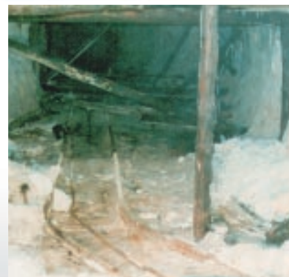
Ein Blick in den Stollen vom vorgetriebe- nen Rohr aus. Seit mehr als 12 Jahren hat niemand den Stollen betreten.
