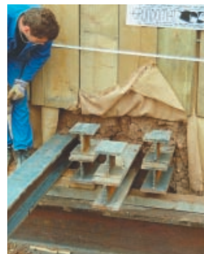
Vorgetriebene IPB Träger 180 mm liegen auf IPB Träger 500 mm. Das kurze aufgeschweißte Trägerstück dient zum Heraus-schlagen der Träger nach der Umsetzung.
