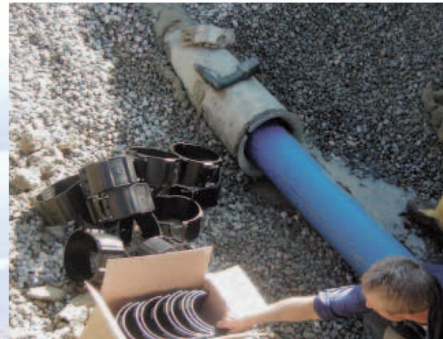
Das Produktrohr wird mit Kunststoff-Gleitkufen in das Schutzrohr eingezogen.
