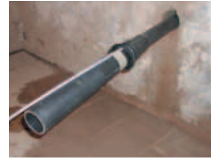
Abb. 7 und Abb. 8 (oben und unten): Die am Rohr installierte Mauerneinführung wird eingezogen.
