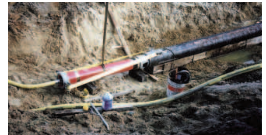
Vortrieb des Stahlrohres mit GRUNDORAM Gigant.
