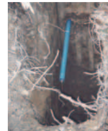
Das eingezogene Schutzrohr (Startgrube).
