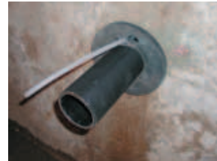
Abb. 7 und Abb. 8 (oben und unten): Die am Rohr installierte Mauerneinführung wird eingezogen.
