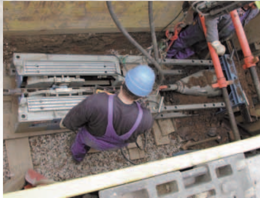
Grabenlose Rohrerneuerung durch das statische Berstliningverfahren (GRUNDOBURST).
