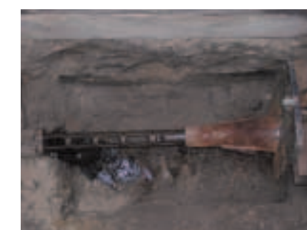
Das Zuggestänge wird nicht verschraubt sondern nur eingeklinkt.
