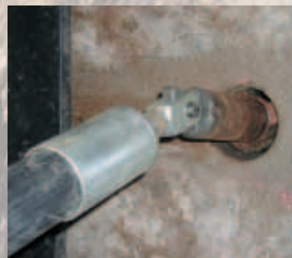
Abb. 6: Einzug des Rohrstrangs.
