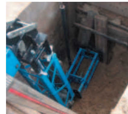
In der Grube installierter Umlenkbaum. Der GRUNDOPULL steht oberhalb der Grube.
