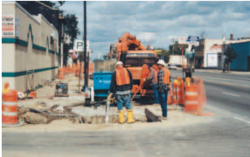
Die Berstlining-Mannschaft setzte den GRUNDWINCH mit einer Zugkapazität von 10 Tonnen ein. Die Winde mit konstantem Zug und variabler Geschwindigkeit spielte eine Schlüsselrolle beim Erfolg des Projekts.
