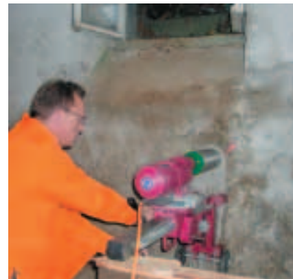
Abb. 4: Herstellung der Kernlochbohrung.
