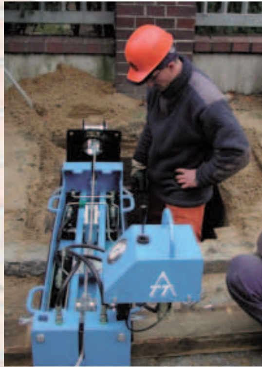
GRUNDOPULL beim Schneiden der Bleileitung.
