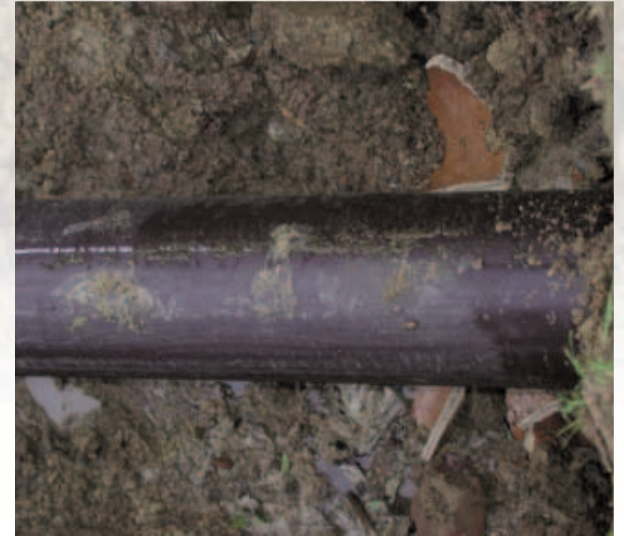
Mit Berstlining erneuertes Abwasserrohr mit Schutzmantel.
