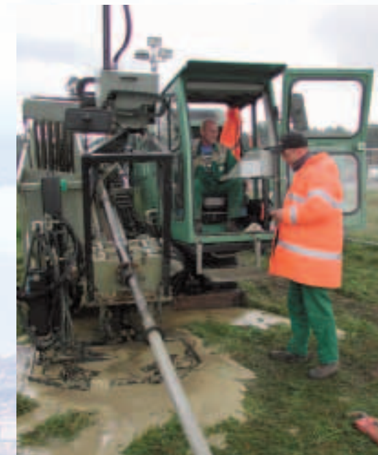
Das Bohrgerät GRUNDO-DRILL 20 S bei einer Räumbohrung.
