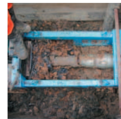
Herausziehen und Schneiden der Altleitung.
