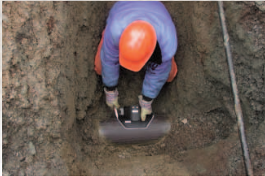
Anbindung der Seitenzuleufe durch passgenaue Friatec-Formteile.
