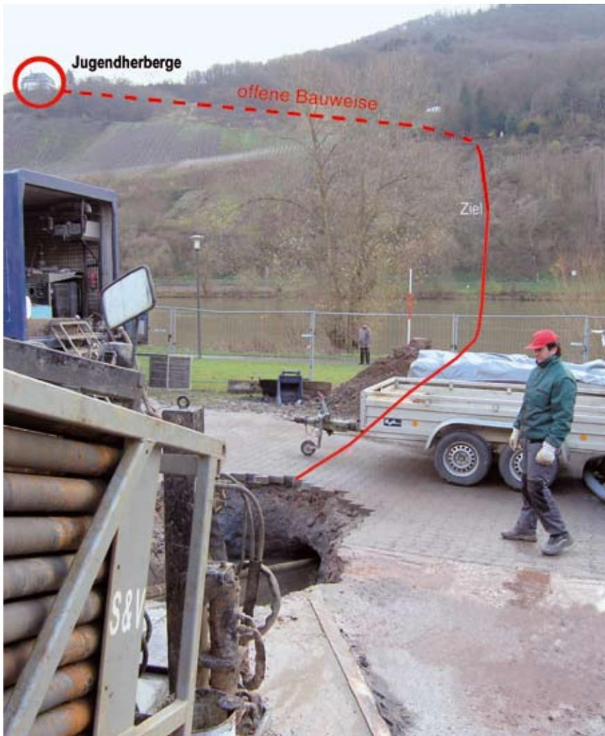
Moseldüker als Felsbohrung in Bernkastel-Kues auf 270 m Länge; Bohrtrasse: 17 m unter dem Wasserspiegel, 13 m unter der Wassersohle bis in einen Steilhang. Zweck: Verlegung einer TWL 180 x 34,6 mm für die Versorgung der Jugendherberge.
