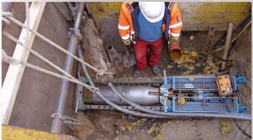
GRUNDOBURST beim letzten Arbeitsschritt: Einzug des Bohrwerkzeugs (Aufweitung).
