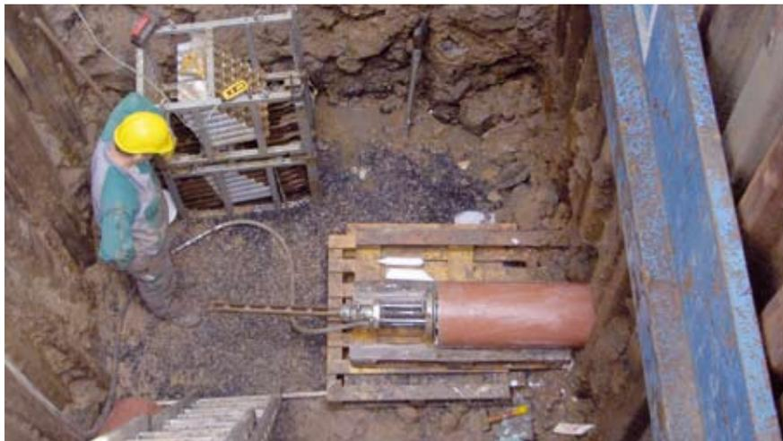
Kurzrohrverspannung mit BURSTFIX.
