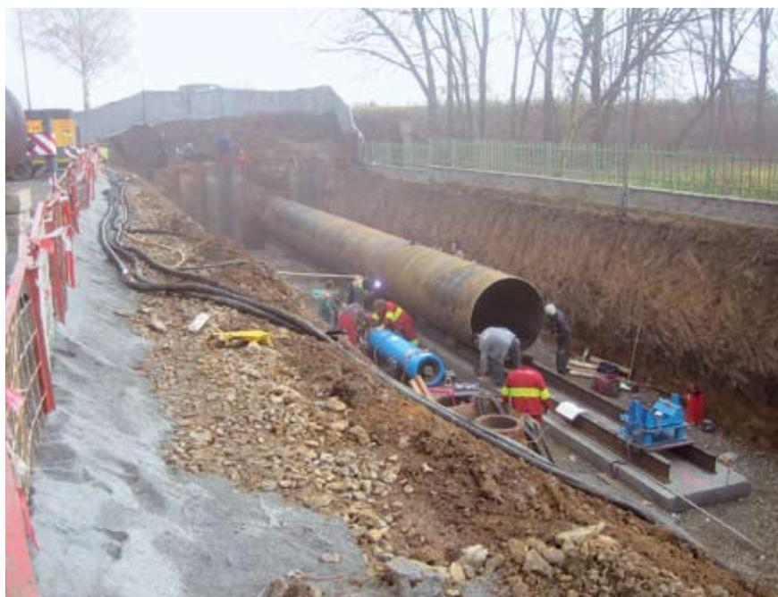
Vorbereitung für den Rammvorgang. Der Stahlrohrstrang liegt auf einem Betonfundament mit I-Stahlträgern als Führungsschiene.
