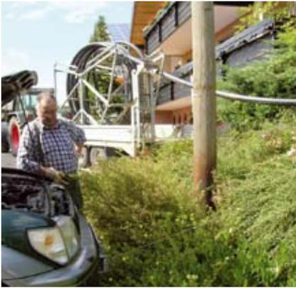
Mit einer Seilwinde wird das neue Kabelschutzrohr über private Gärten hinweg den Hang bis zur Zielgrube hochgezogen und dort in das freie Bohrloch der Altkabeltrasse hineingezogen.
