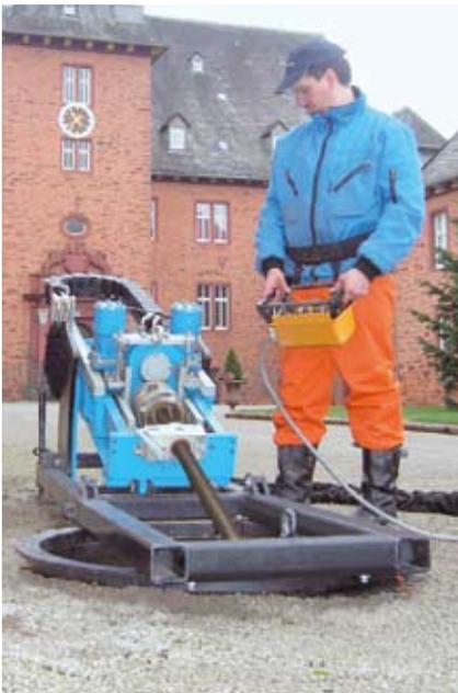
Verlegesystem auf Drehkranz in Arbeitsposition.
