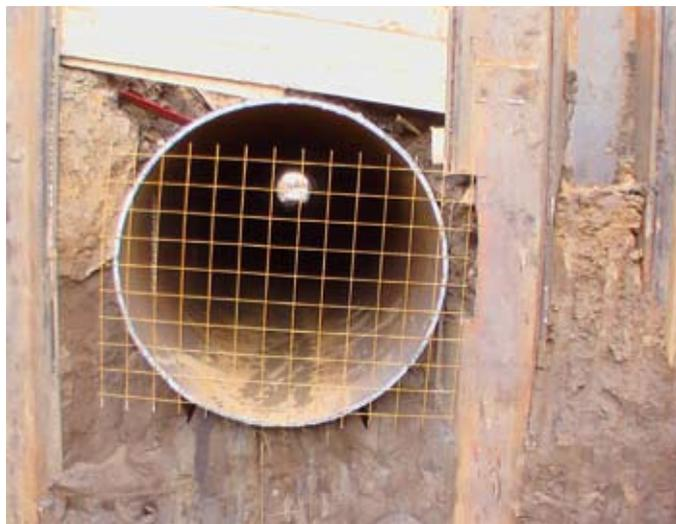
Das eingerammte und vom Erdreich geräumte I.800er-Stahlrohr.
